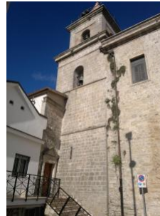
Torre campanaria dell'Assunta
